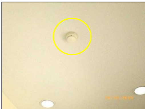
รูปที่ 2-20 อุปกรณ์ตรวจจับควัน (Smoke Detector)
