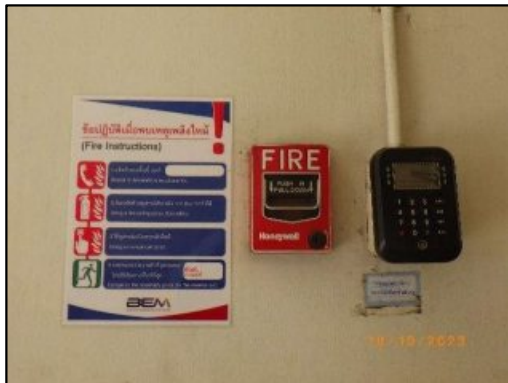
รูปที่ 2-19 อุปกรณ์แจ้งเหตุฉุกเฉิน (Fire Alarm)
