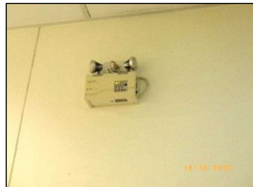
รูปที่ 2-21 ไฟฉุกเฉิน (Emergency Light)
