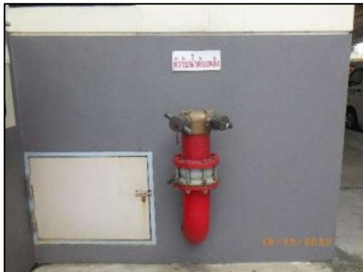
รูปที่ 2-24 หัวรับน้ำดับเพลิง (Fire Hydrants)
