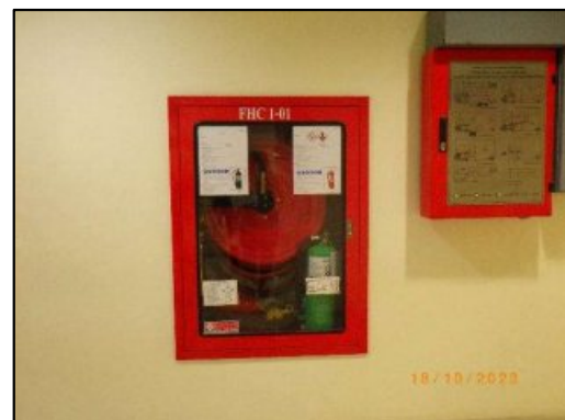
รูปที่ 2-23 ตู้เก็บสายฉีดน้ำดับเพลิง (Fire Hose Cabinet)
