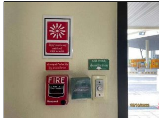
รูปที่ 2-19 อุปกรณ์แจ้งเหตุฉุกเฉิน (Fire Alarm)
